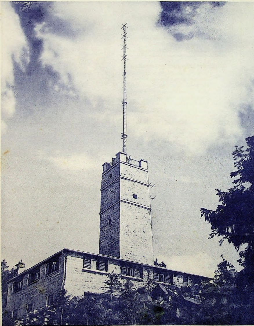
Seit Mitte Oktober hat der neue 10-kW-UKW-FM-Rundfunksender des Bayerischen Rundfunks auf dem Ochsenkopf (Fichtelgebirge) in 1025 m Höhe den Versuchsbetrieb (Frequenz 88,5 MHz) aufgenommen. Die Sendeanlage gehört zu den modernsten Anlagen und verwendet eine 4-fach-Quirlantenne mit Horizontalcharakteristik. Der Antennenschaft, der die eigentliche Sendeantenne trägt, besitzt einen Durchmesser von 42 cm. (Archivfoto: Technische-Direktion, Bayerischer Rundfunk)
